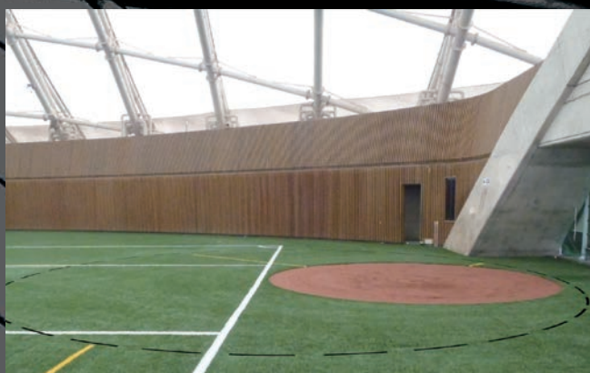
人工芝グラウンド用途切替ターンテーブル Φ13000・40000kg仕様
