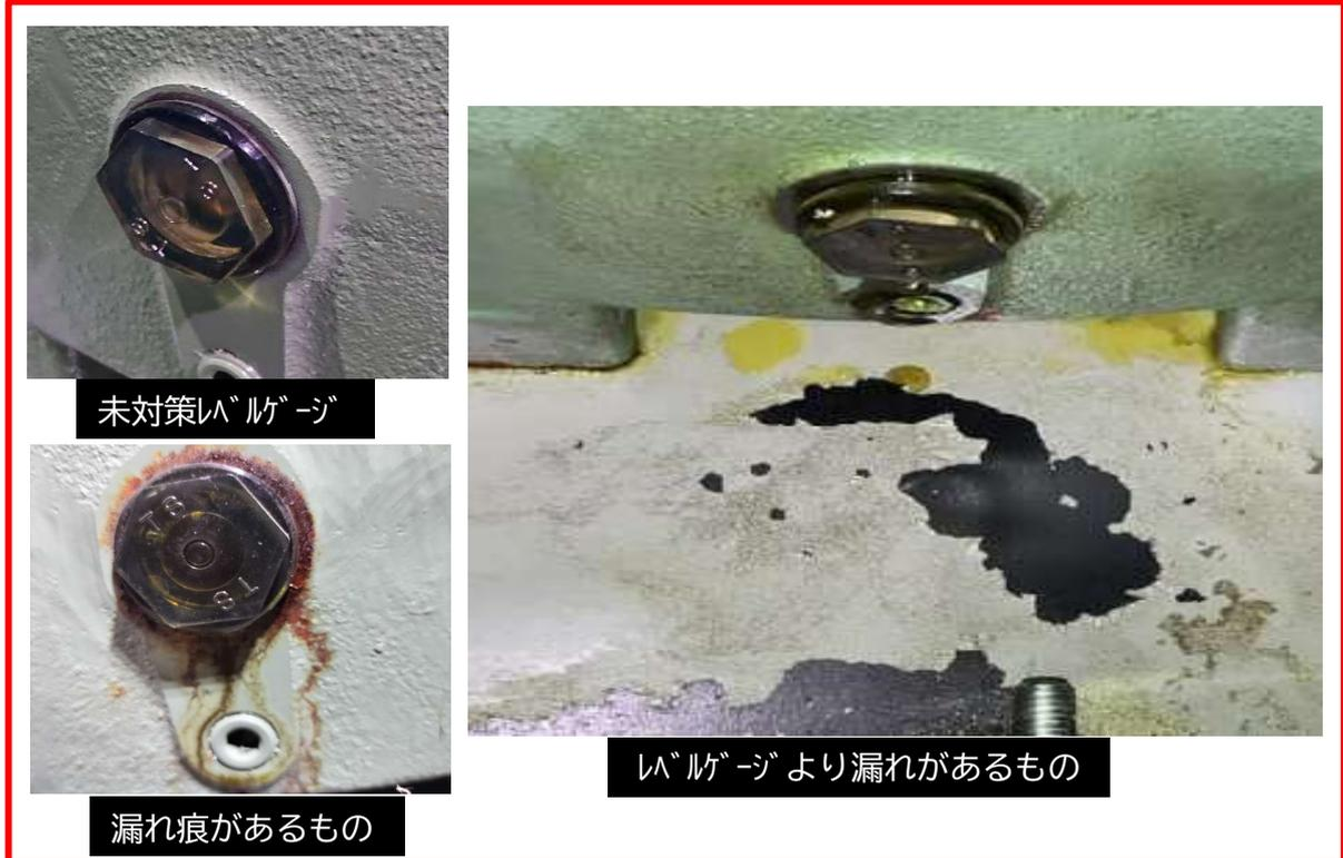
バルブゲージが破損していないものは油量を確認する。
