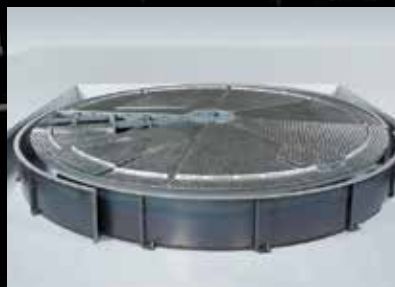
④コーナースクランブル取付 コーナースクランブル兼鋼板製型枠の 組立。
