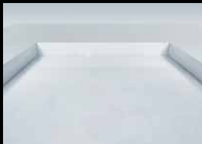
①施工前ピット フラットなピットに墨出して 施工開始。
