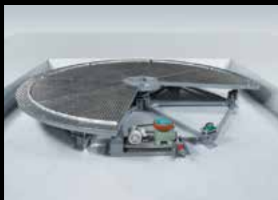
③天板取付 上部天板を取付し駆動装置の 調整。
